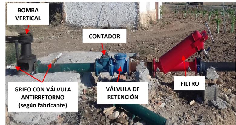
**BOMBAS SUMERGIDAS:** contador, válvula de retención.
